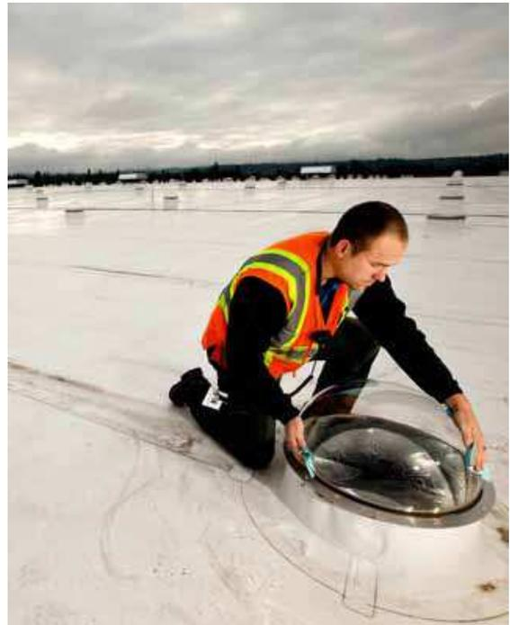
Los tubos solares ubicados en los techos del Flatbed Distribution Center de Lowe's en Centralia, Washington, pueden proporcionar luz suficiente incluso en días nublados.
